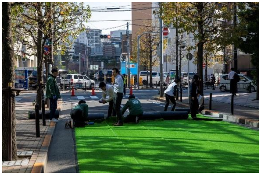
人工芝敷設状況
