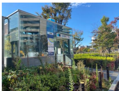
地上接続エレベーター
