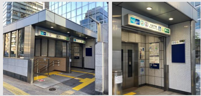
地下鉄出入口（7番付近）
