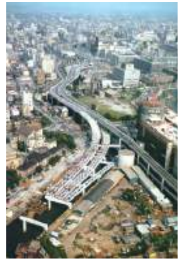
▲建設中の首都高速道路
