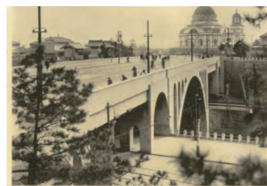
▲建設当初の聖橋
