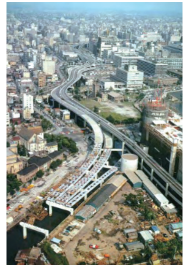
▲建設中の首都高速道路
