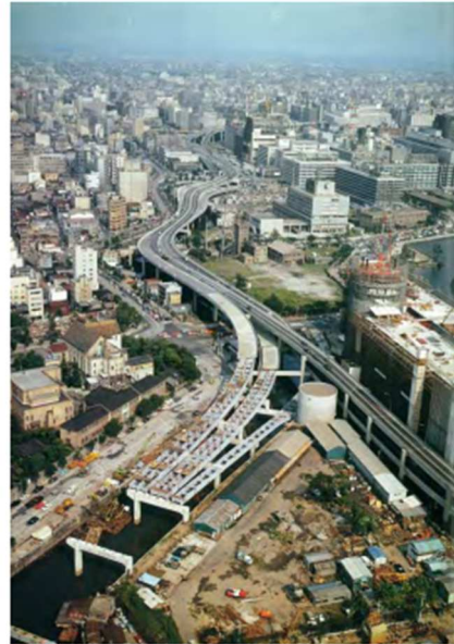
図 建設中の首都高速道路
