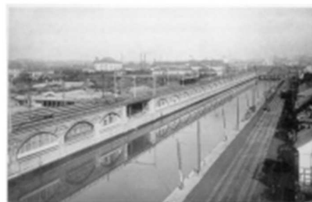
図 外濠沿いに建設された鉄道
