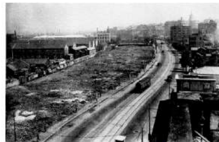
図 5-2 埋め立てられた外濠(東京駅八重洲口付近外濠)
