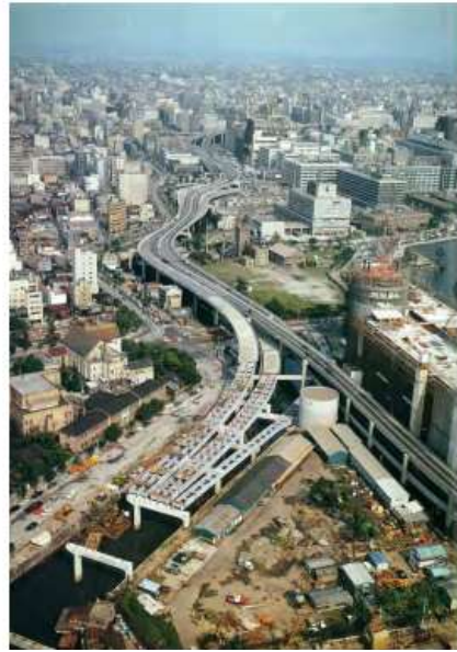
図 建設中の首都高速道路
