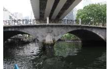
常磐橋（震災復興橋りょう）
