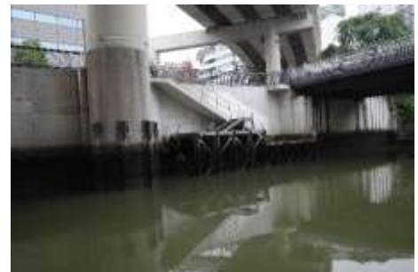
現在の防災船着場（新三崎橋）
