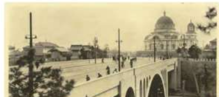
建設当初の聖橋
