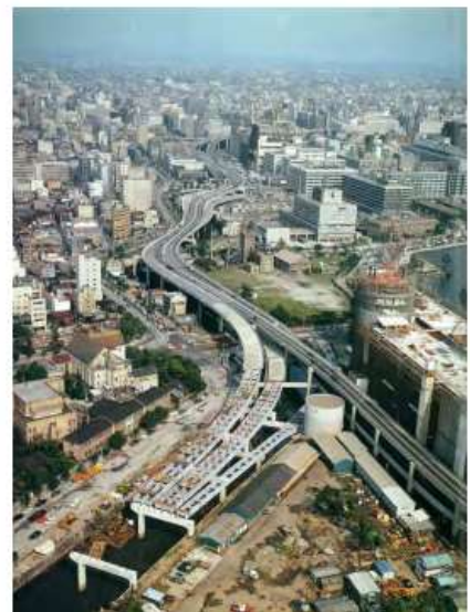
図 建設中の首都高速道路
