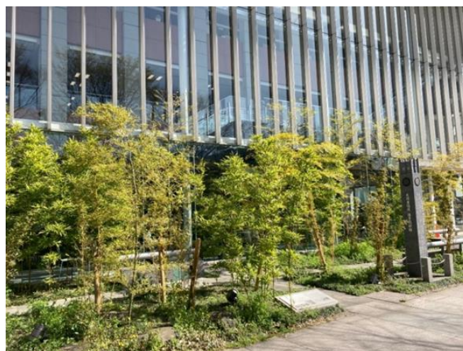
千代田区役所本庁舎
