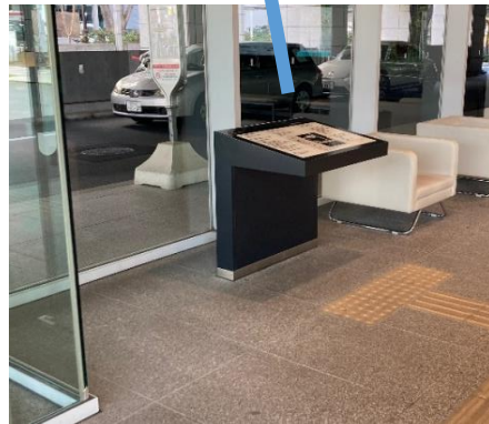
点字案内板、誘導・注意喚起ブロック
