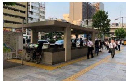
・ 地下鉄利用者の多くが道路上にある出入口の階段を利用 ・ 上りエスカレーターが、途中で止まらない
