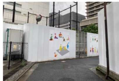
・ 視認性の悪いクランクした道路がある
