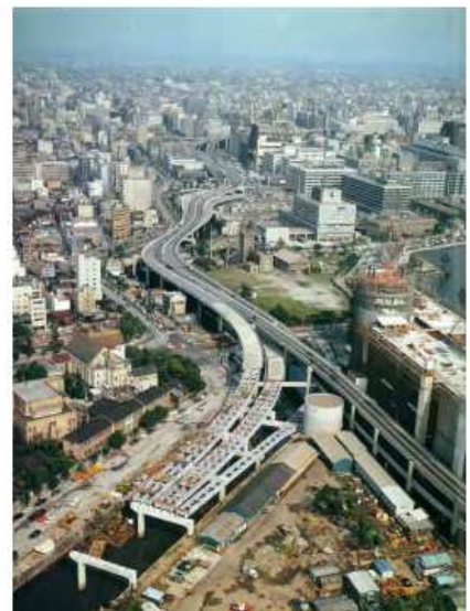
▲ 建設中の首都高速道路
