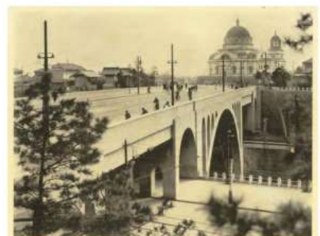
▲ 建設当初の聖橋
