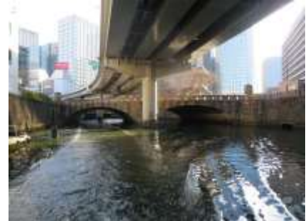
▲常盤橋（震災復興橋りょう）
