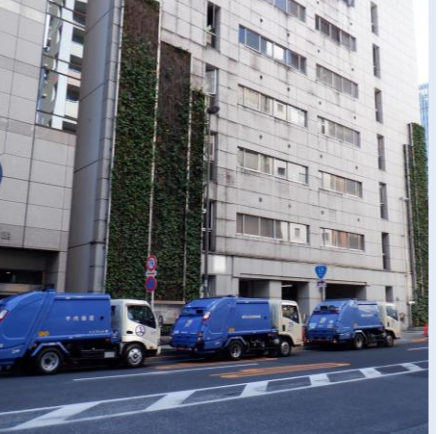
清掃車両駐車スペース不足による、前面道路での清掃車の路上停車
