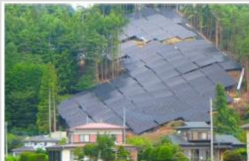
森林を伐採し、斜面に設置された事例
