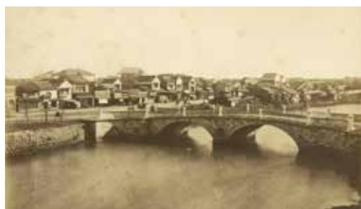
図8 常盤橋古写真(明治初期)
