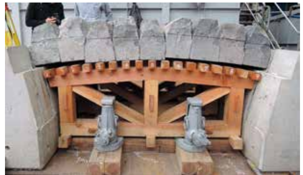
図5-2 試験施工に用いたモックアップ
