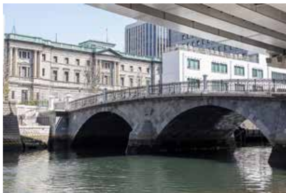
図 5-1 視点場からみる常磐橋と日銀本店本館
