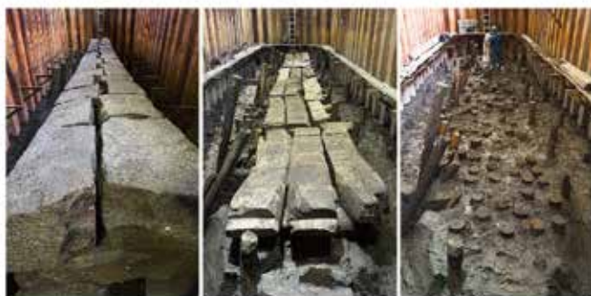
図 2-36 基礎構造（左：巻出石 中：捨土台 右：地形杭）
