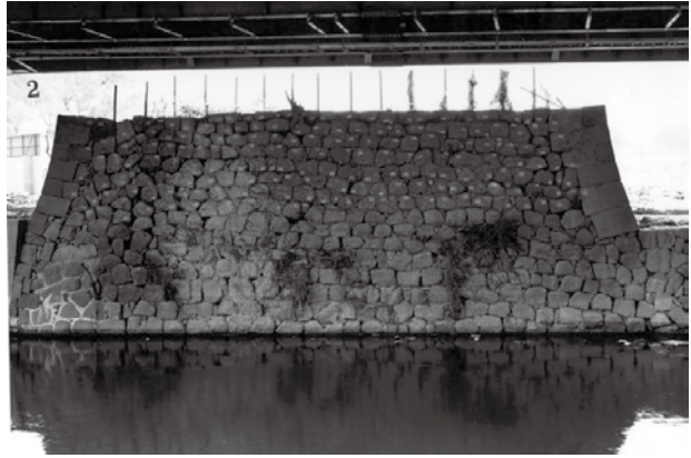
図 3-12 錦橋東方の隅角部石垣
