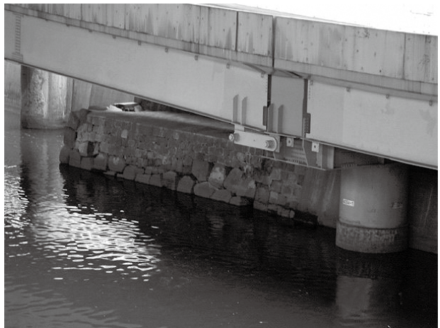
図 3-14 神田橋東方の橋台石垣の一部
