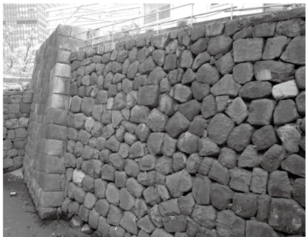
図 3-15 常盤橋門跡周辺の石垣
