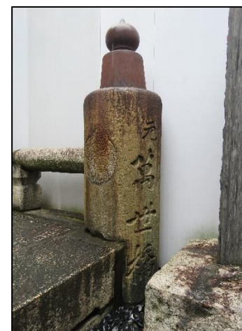
親柱・欄干 （前面右側）
