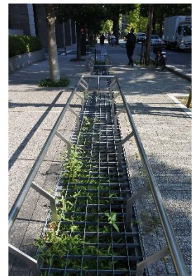
三井住友海上駿河台新館前のレインガーデン 底は土壌となっており、周囲からの雨水を浸透させています 土壌のため植物が生育します
