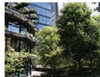
三井住友海上駿河台新館 ECOM 駿河台
