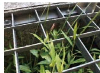
三井住友海上駿河台新館前のレインガーデン 底は土壌となっており、周囲からの雨水を浸透させて植物が生育します。
