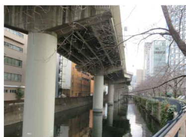
水辺の生きものの生息に適さない河川環境（日本橋川（新三崎橋付近））
