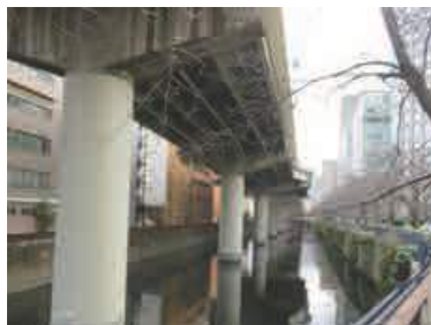
■ 日本橋川（新三崎橋付近）
