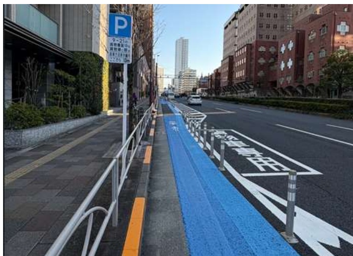
図 4-8 国道1号(港区白金1丁目～高輪台)の整備事例
