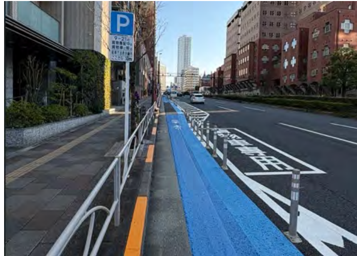
図 4-8 国道1号(白金1丁目～高輪台)の整備事例
