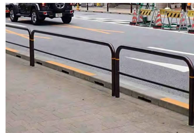
横断防止柵(参考) ※人の横断を抑止する柵
