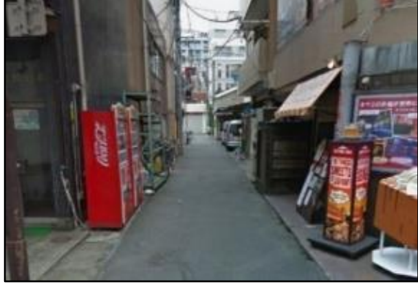
老朽化した建物や、見通しが悪い細街路があり防犯上の懸念がある
