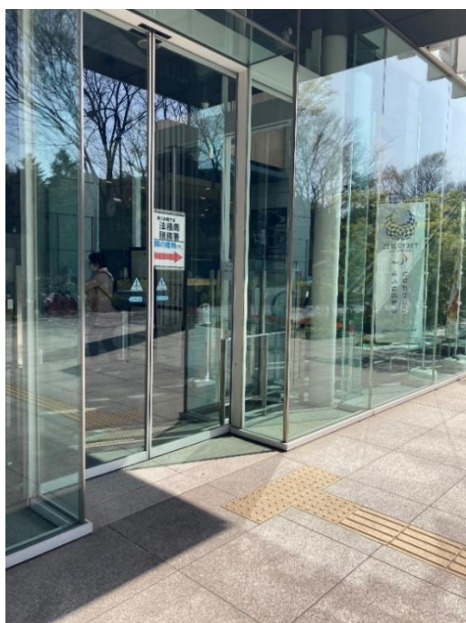
自動ドア、誘導・注意喚起ブロック
