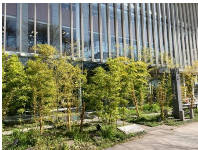
図表 6-5 千代田区役所本庁舎
