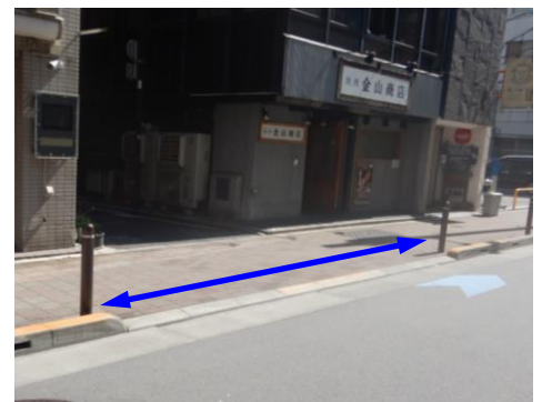
整備事例 一八通り 歩道のアップダウンが解消 →車いすやベビーカーが通りやすく
