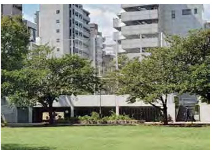
校庭との境界部にある壁面
