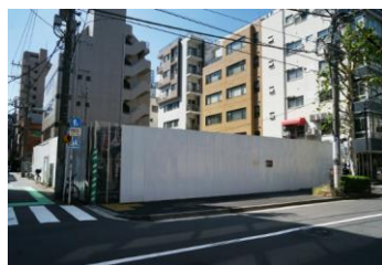
旧和泉町ポンプ所跡地
