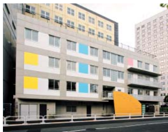
神田保育園仮園舎
