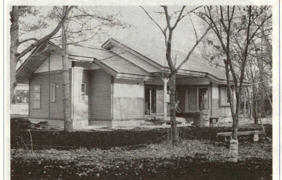
▲内装工事が着々と進むコテージ棟
