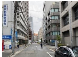
無電柱化前 (出世不動通り-本郷通り以西)
