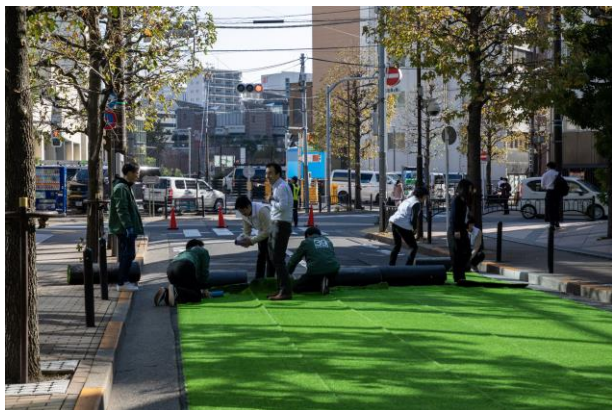
人工芝敷設状況
