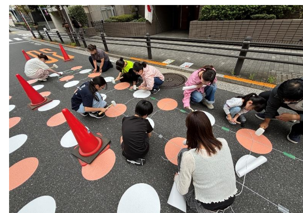
図6 路面標示設置状況
