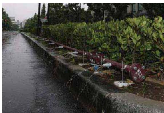
図 散水管からの散水の様子
