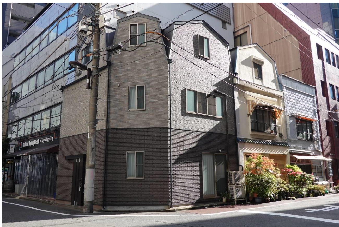
▲改築後も 3 連のマンサード屋根が継承された志村印刷
