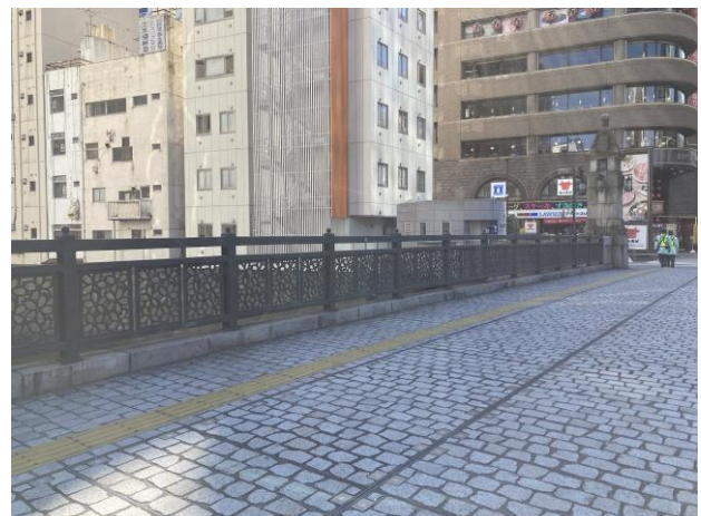
▲花柄の高欄と化粧舗装された路面
