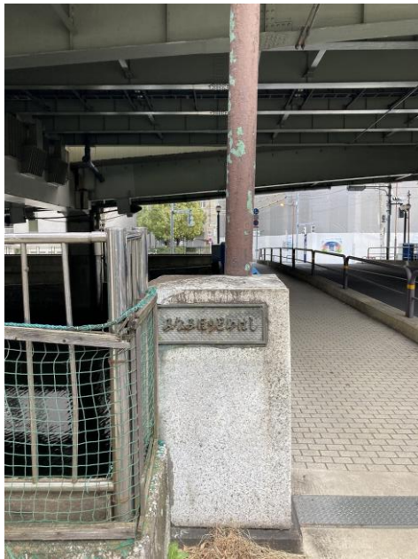
▲南堀留橋の親柱
