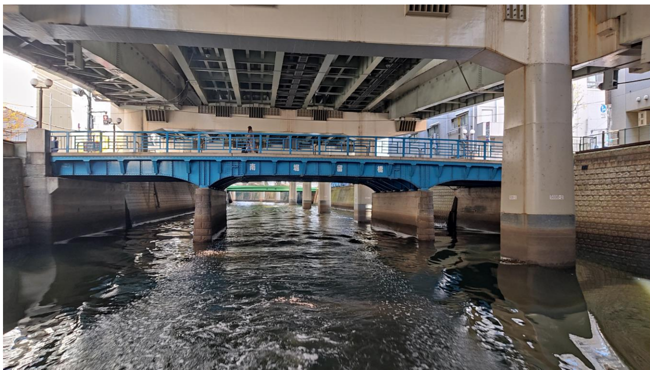
▲南堀留橋全景
