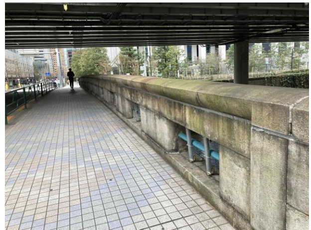
▲特徴的な高欄とタイル貼りの歩道
