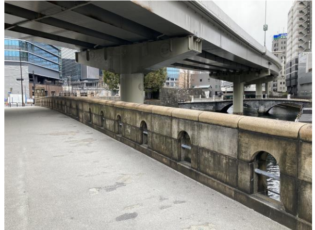
▲小アーチをくりぬいた高欄
