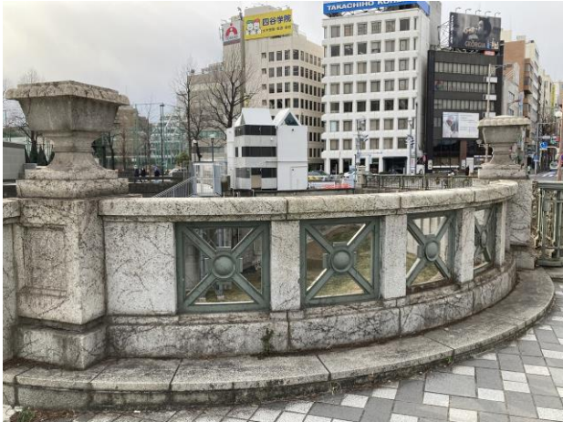
▲橋詰付近の高欄
