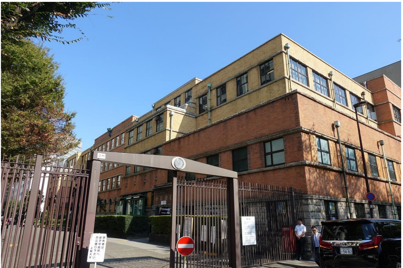
▲上智大学一号館
