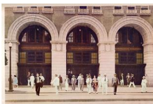
昭和初期の丸ビル入口
