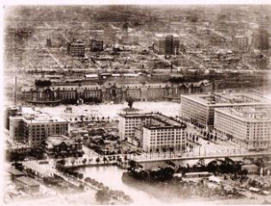
関東大震災直後の丸の内
