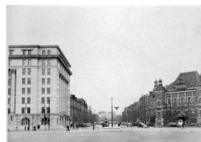
明治期の馬場先通り(二重橋前) 右手に東京商工会議所、 左手に明治生命を望む
