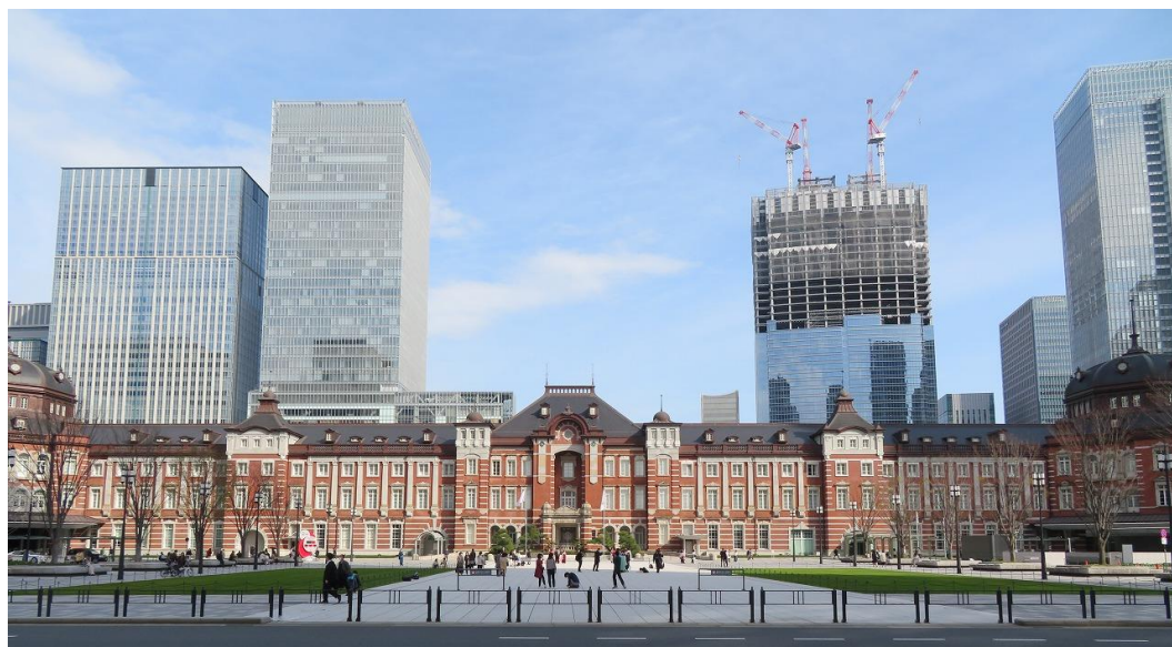
▲東京駅丸の内駅前広場 (丸の内一丁目)
