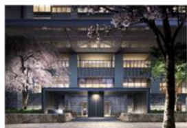
●石垣のグランドエントランス グランドエントランスの石垣は、歴史的資産の改修を多数手掛ける事業者により周辺との調和が意識されている
