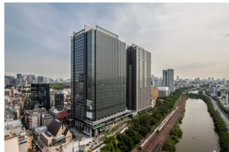
飯田橋サクラパーク（飯田橋駅西口地区）
