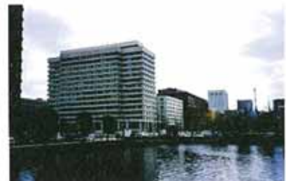
和田倉濠沿いのうるおいある空間
