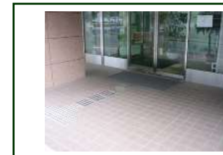
道路等と段差のない出入口
