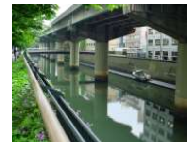
高架が水面を被う日本橋川
