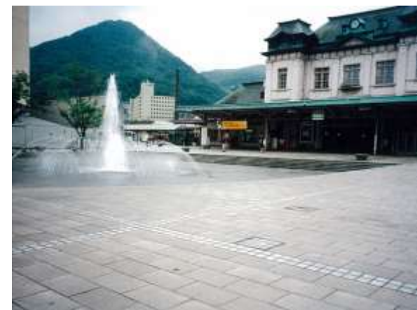
文化財と調和した駅及び駅前広場の整備（写真：門司港駅前広場）
