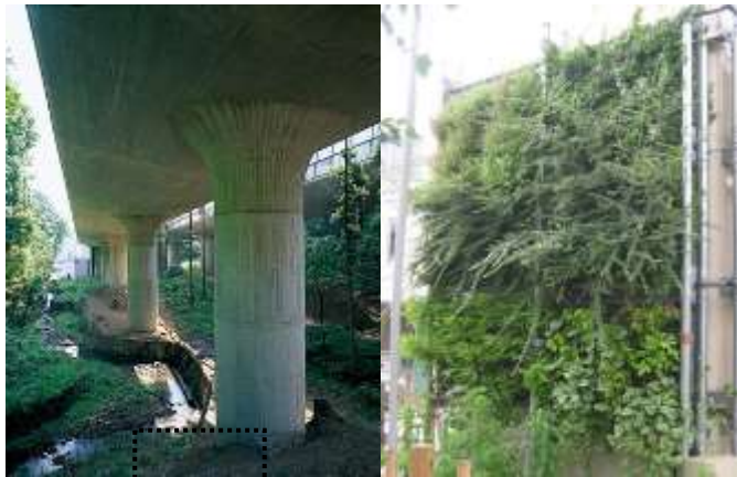
桁下のデザイン化・壁面緑化
