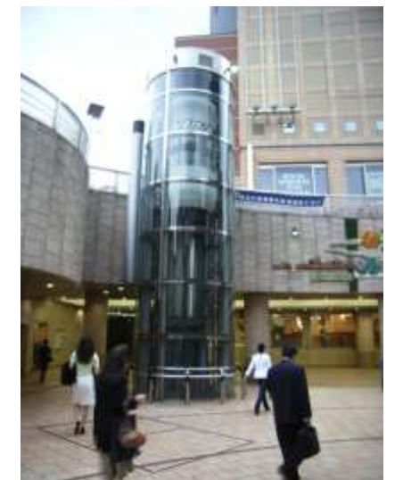
誰もが使いやすいエレベーターの設置（西口⇄ホーム、地下⇄地上）
