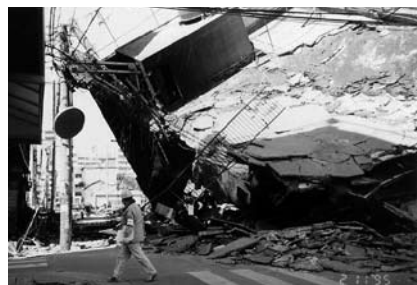
▲阪神淡路大震災で倒壊した建物に塞がれた道路(写真:財消防科学総合センター)
