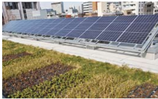
▲太陽光発電・屋上緑化
